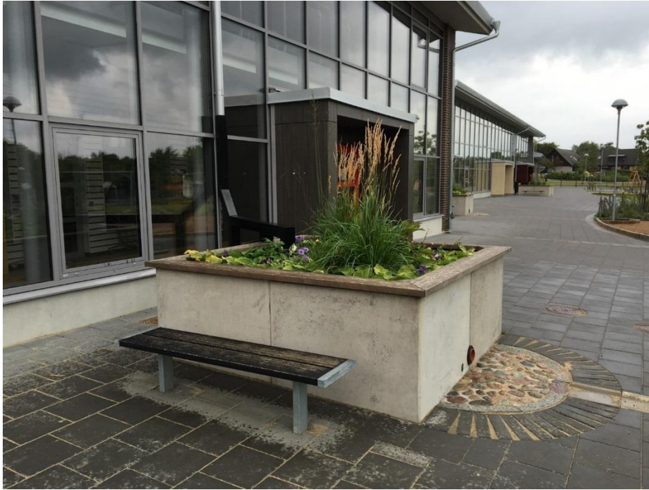
Bild 4: Växtbädd som hanterar dagvatten från stuprör, Parkskolan i Dalby (foto: Kent Fridell).
